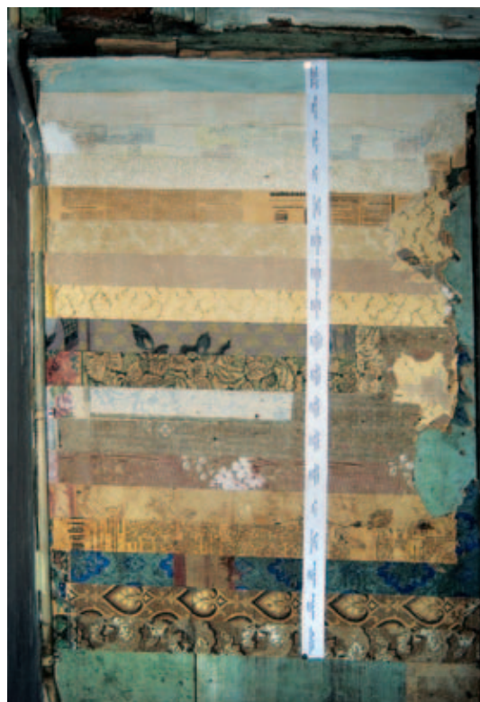
6 Tapetenabtrepplung mit Datierung.
