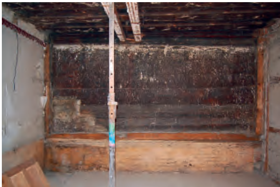
2 St. Gallen (CH), Fehr'sches Schössli, Stube von 1532 (d) mit Schwarzfassungen während des Umbaus.
